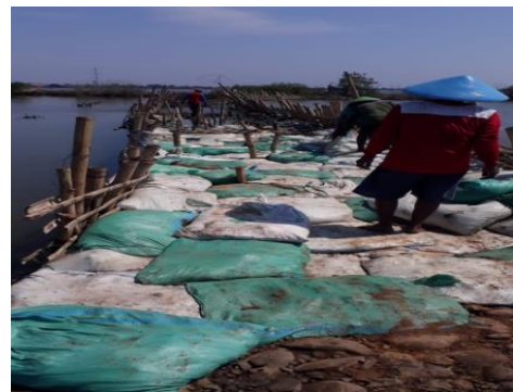
Gambar 4. 16 Pembangunan Tanggul non permanen
